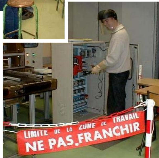
Dépannage et remise en production
